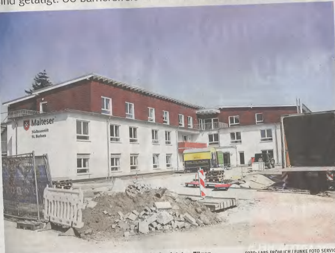
Die Arbeiten am Malteserstift St. Barbara liegen in den letzten Zügen.
