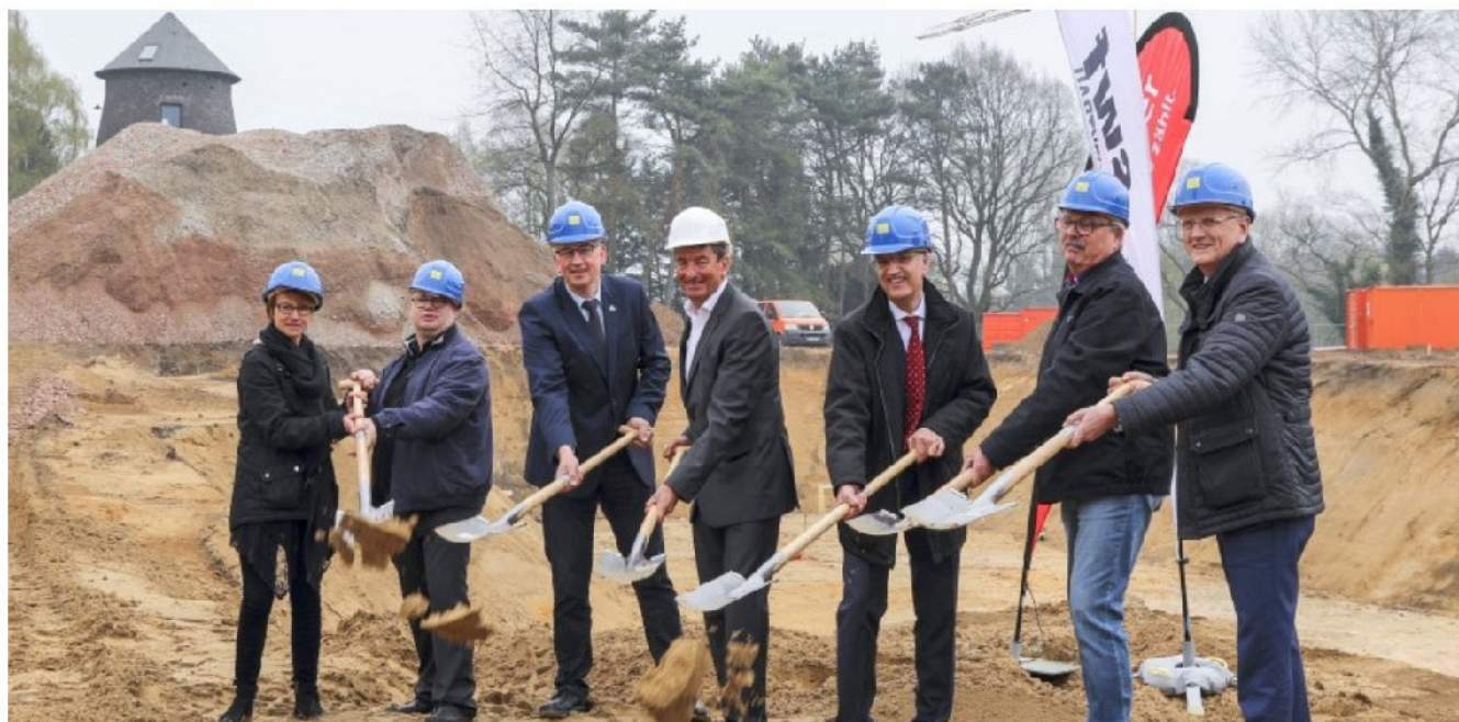
Erster Spatenstich im Baugebiet Högemannshof, Alte Weseler Straße 12a in Hünxe, für das Malteserstift St. Barbara (v.l.n.r.): Pastorin Hanna Maas, Pastor Johannes Werges, Hauptamtsleiter Klaus Stratenwerth, Bauherr und Investor Georg Spitzer, Gerhard Bremekamp (Vorstand Volksbank Dinslaken), Architekt Thomas Hampf und Roland Niles (Geschäftsführer Malteser Rhein-Ruhr gGmbH). Foto: Erwin Pottgiesser
